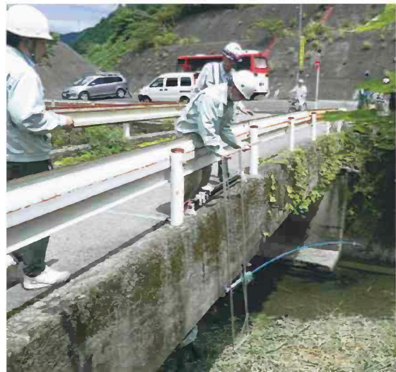
中村建設と共同で開発したロボットを使って橋の下部を点検する沼津高専の学生
