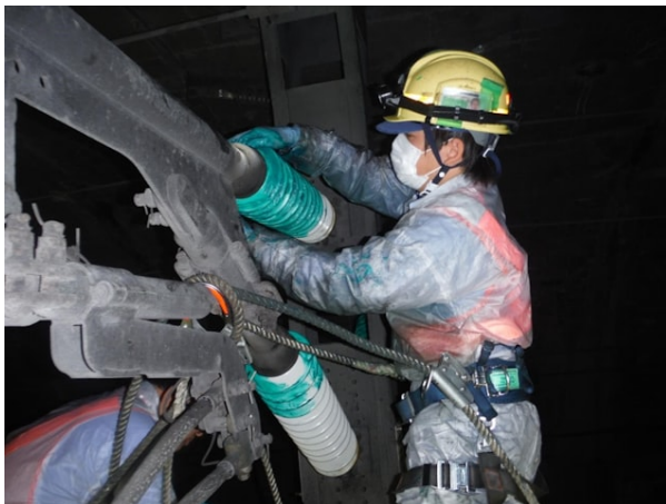
がいしの塗り替え作業の様子=JR東海提供
