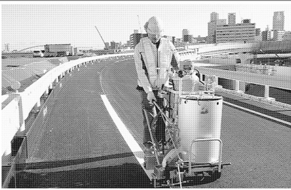
路面標示用塗料にも二酸化炭素を吸収する人工石灰石を活用する
