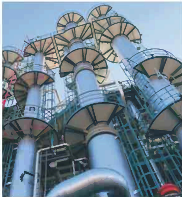
三重県四日市市に冷凍機油原料のプラントを増設した
