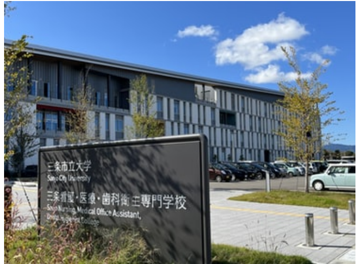
モダンな校舎の三条市立大学は上越新幹線燕三条駅から間近な場所にある
