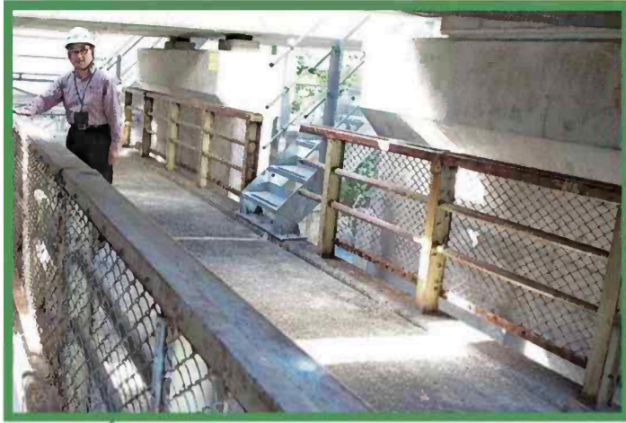
1959年 国内初の西枇杷(びわ)島歩道橋(愛知県)
