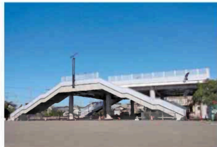
津波避難タワーの機能を持たせた横断歩道橋が、2013〜14年、静岡県吉田町の町道上6カ所に出現した。歩道橋部分を拡張して人工広場と
