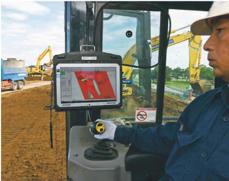
堤防工事でGPSを使い、踏み固めた位置と回数を確認する作業員（6月、さいたま市桜区）
